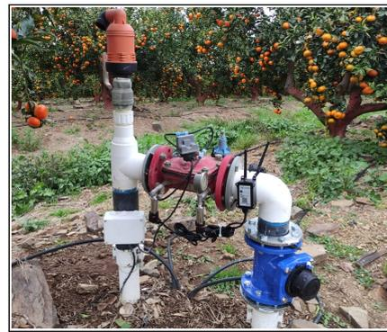
Figura 2: Hidrante con válvula reductora, ventosa y sensores de presión y caudal.
